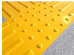
■ 警告ブロック
