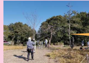
ロープで倒す方向を調整し伐採
