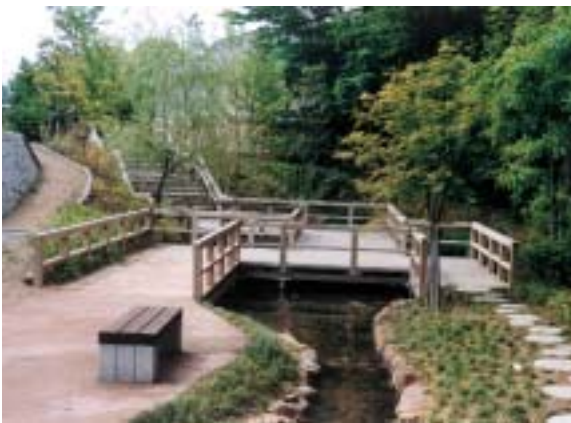
ふるさとの川整備事業の栈橋
