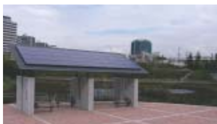
和泉中央公園への太陽光発電による噴水の設置
