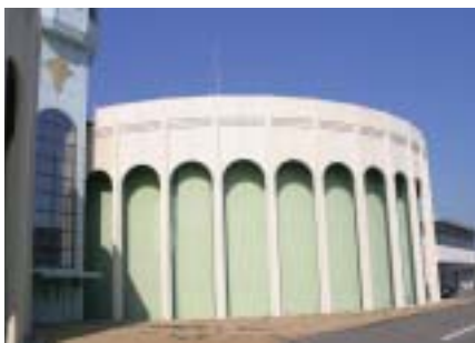
中央受配水場
