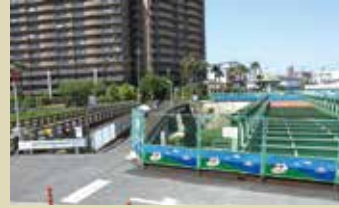
安全な道路施設整備の推進「繁和橋橋梁架替事業」
