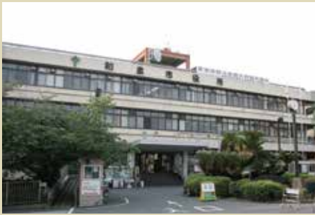
防災拠点の確保「庁舎整備事業」
