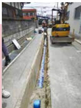
水道管更新工事の様子
