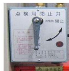
閉止弁を「閉」にする
