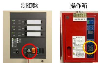
切替えスイッチを「手動」にする
