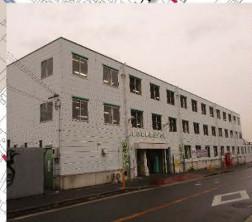
信太山駅前自転車等駐輪場 建築年:平成13年
