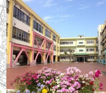
幸小学校 建築年:昭和43年 指定:指定避難所
