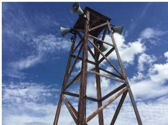
建築設備の囲障に著しい損傷、変形、腐食がある
