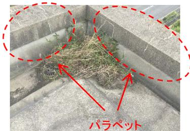
笠木に著しい浮きやき裂等の損傷、変形や腐食による脱落の恐れがある
