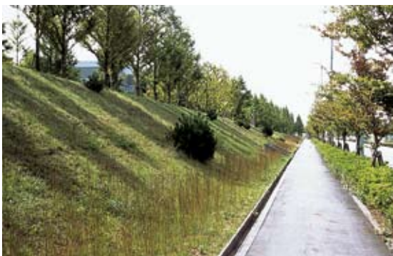
フェンス等を設けずに開放的な沿道景観の形成に配慮している例
