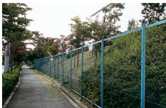
法面下部にフェンスを設け 歩道景観を圧迫している悪い例
