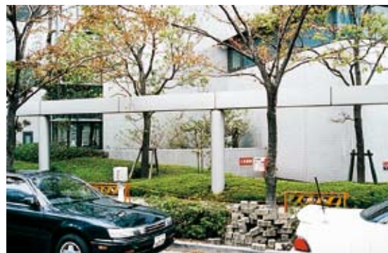
構造物による屋外施設修景例
