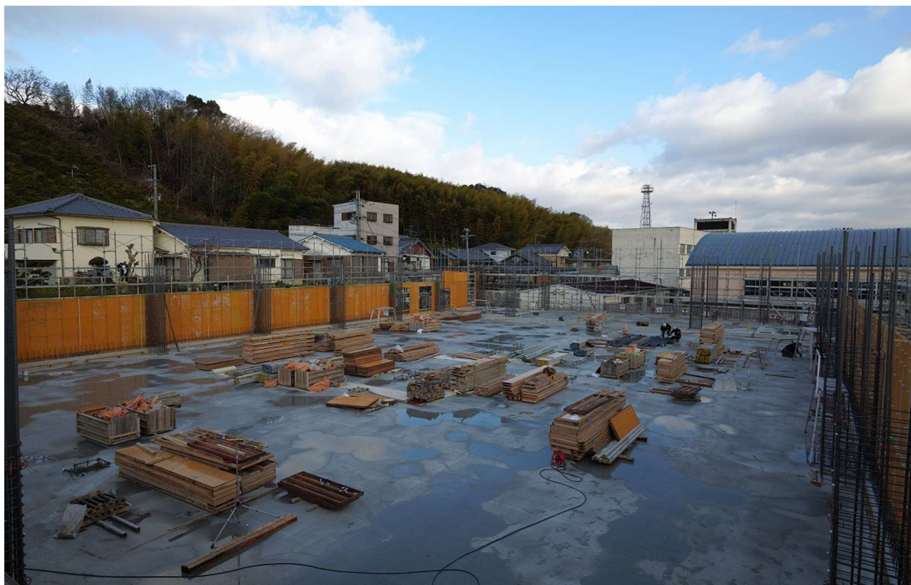
体育館の建設①
