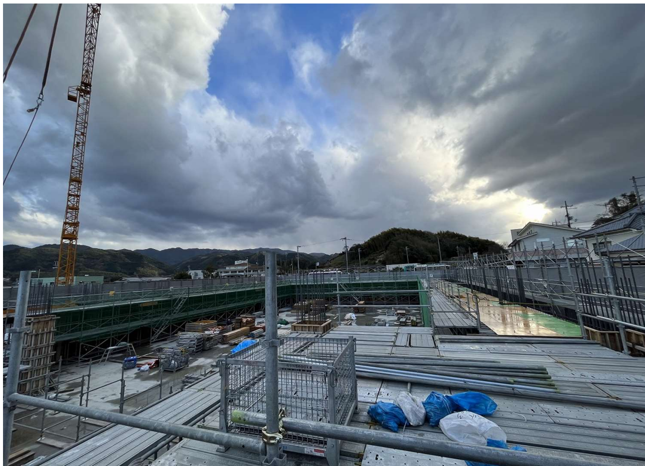
体育館の建設②
