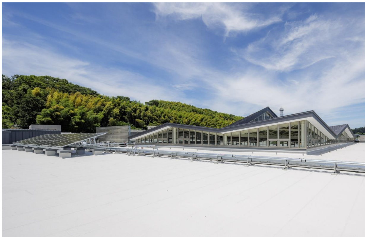
校舎棟：屋上、太陽光発電
