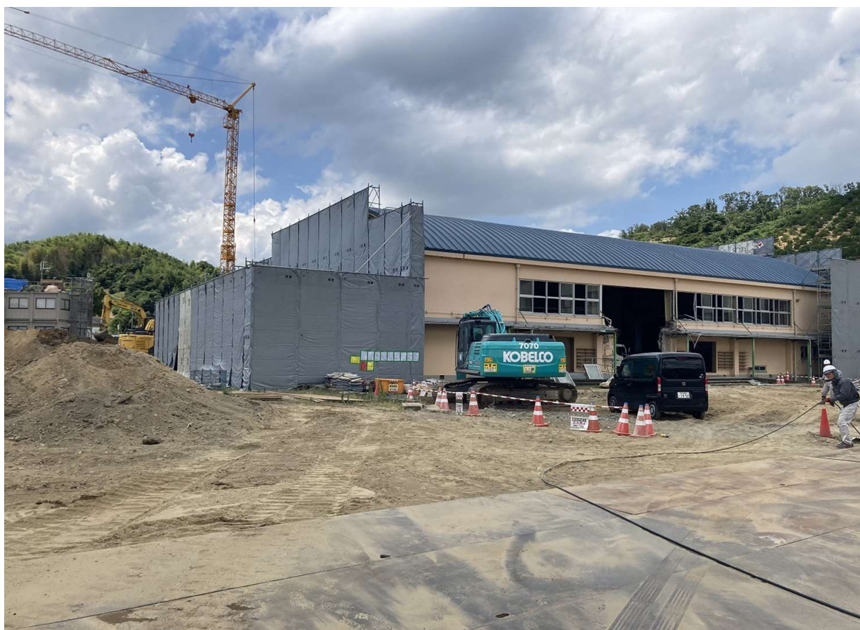
旧体育館解体
