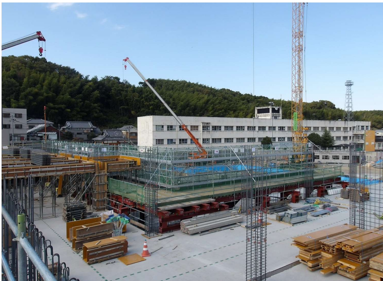
新校舍基礎工事③
