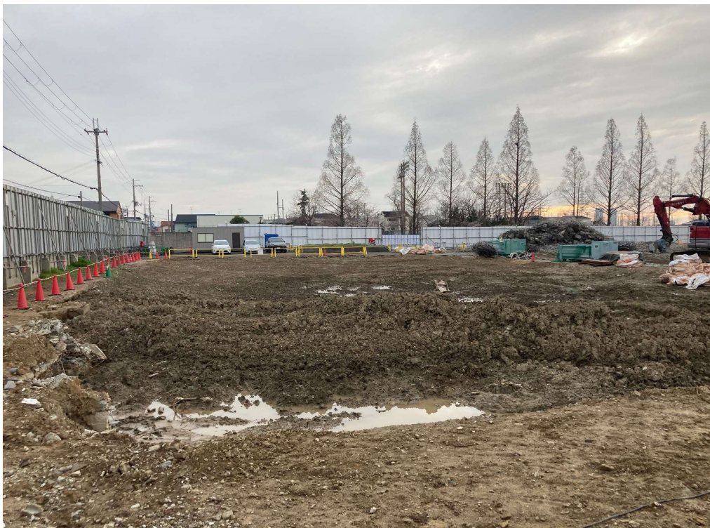
専用講堂解体完了
