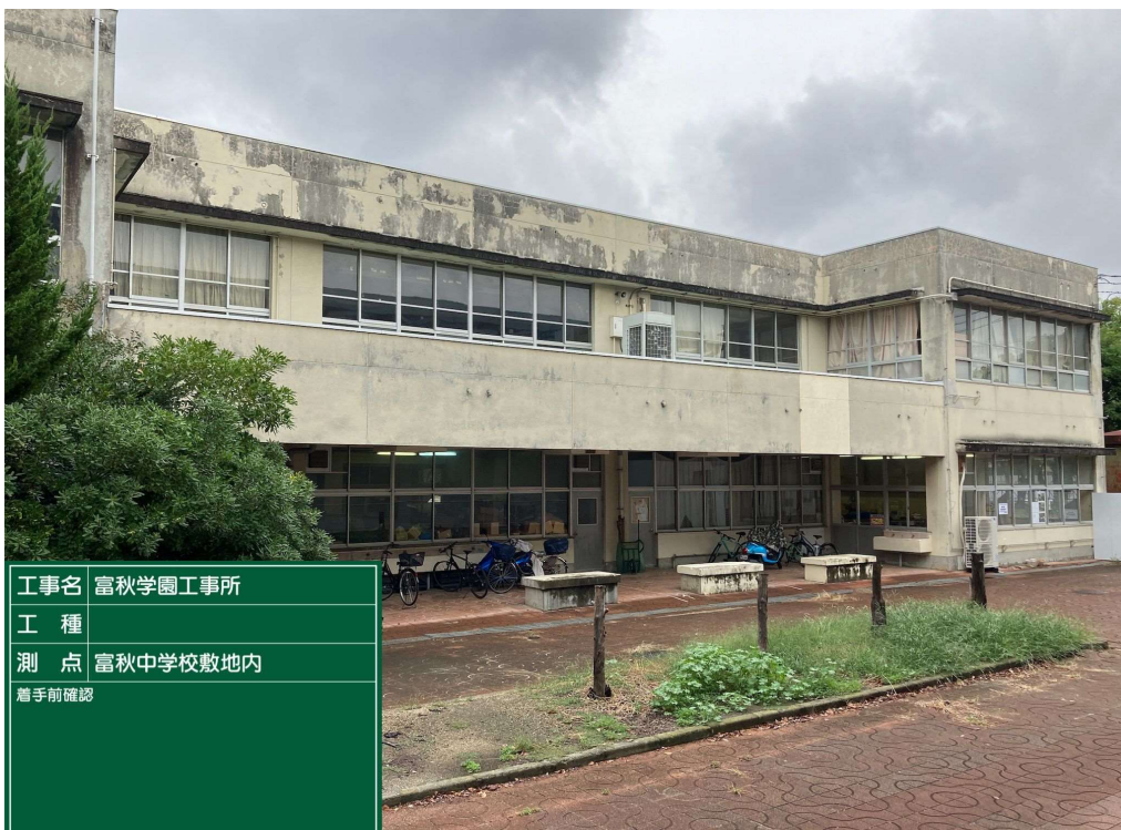
特別教室棟解体前
