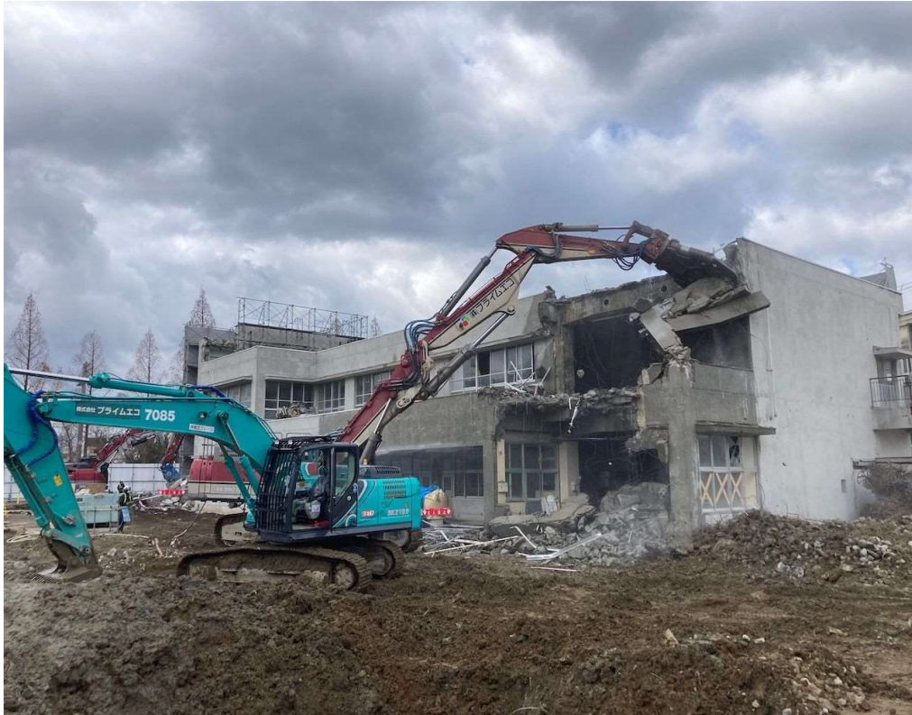
特別教室棟解体中
