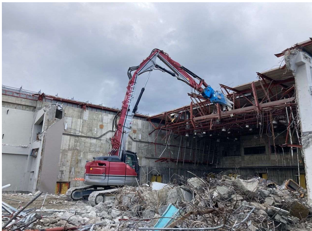
専用講堂解体中
