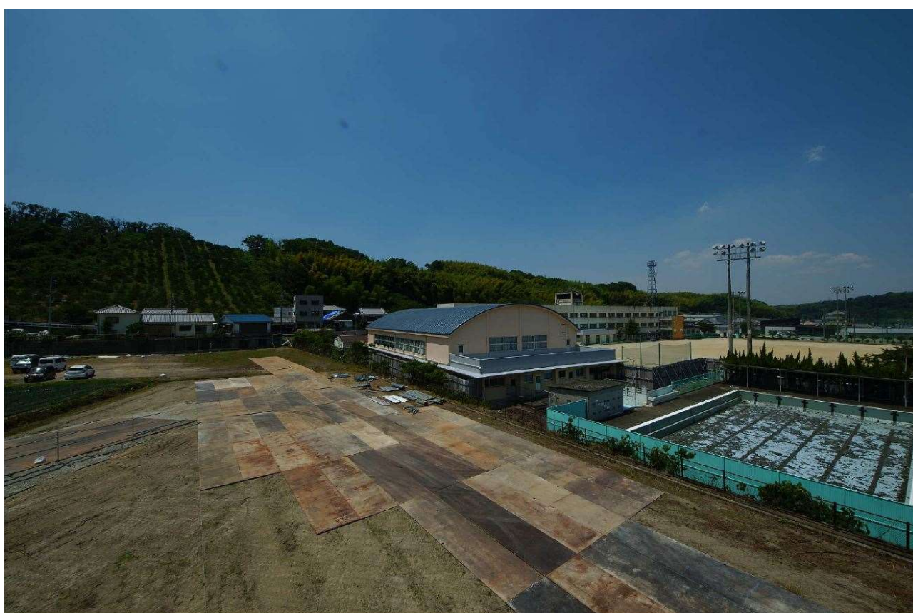
現場事務所から
