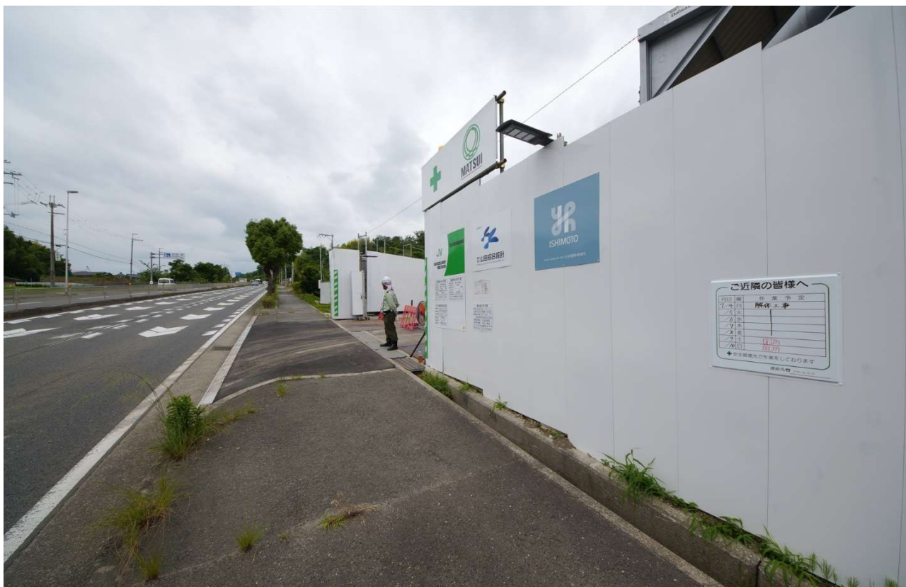
仮囲いの設置
