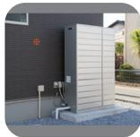
都市ガスなどを燃料とし、電力と熱を同時に生成します。エネルギーを効率よく使うことで、購入電力を削減することができます。
