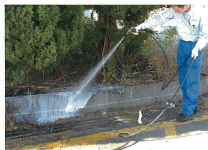
専門業者による液剤の高圧散布
