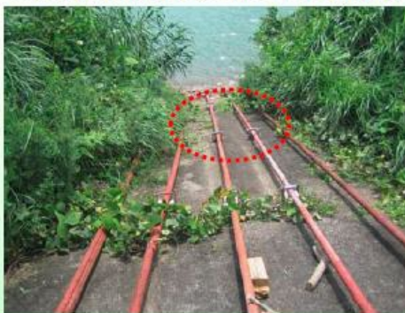
⑤ 斜樋の破損(スピンドル挫屈)
