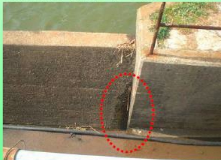
⑧ 継目、亀裂からの漏水(水路壁の変色)
