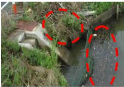
土砂、ゴミ等による取水阻害
