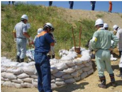
土のう作成・設置の訓練の事例
