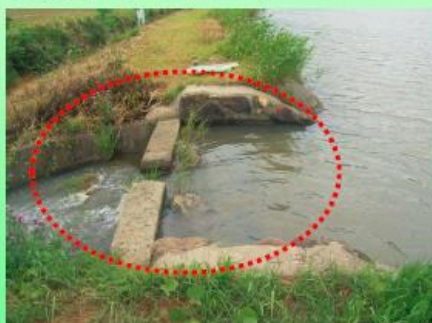
⑦ 洪水吐の堰上げ
