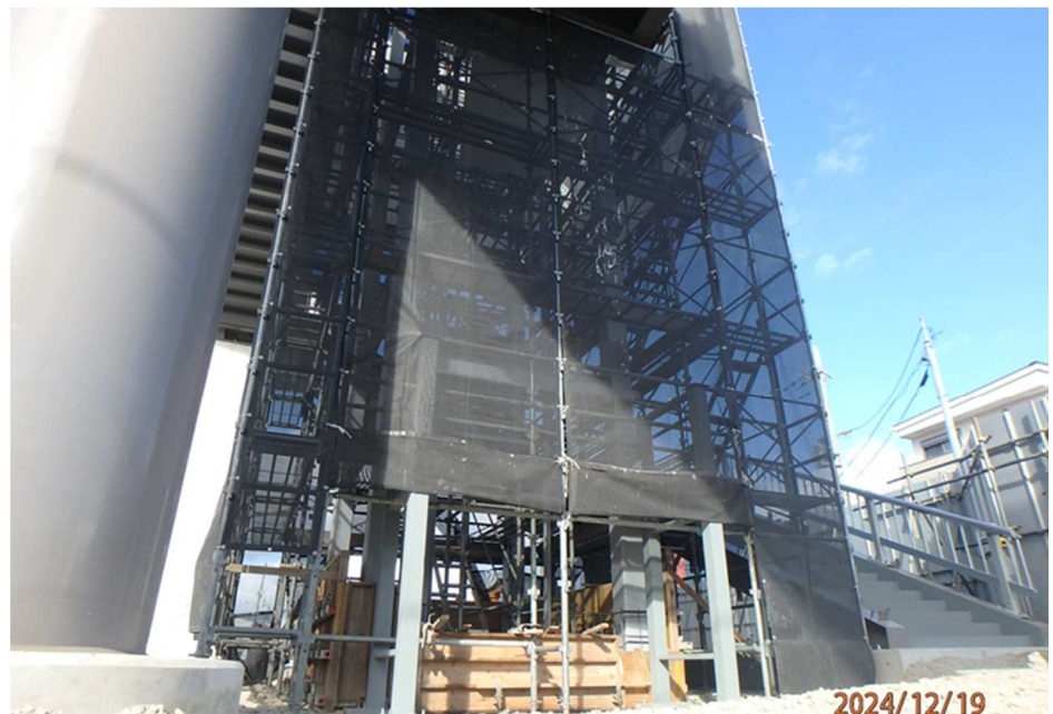
4 自由通路エレベーター設置前の状況（西側）
