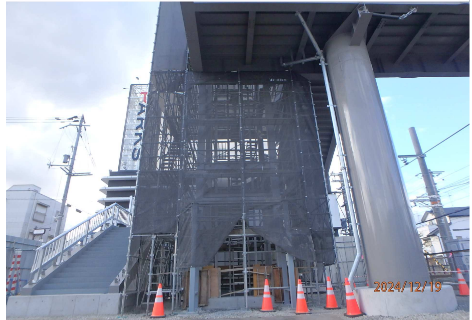
2 自由通路エレベーター設置前の状況（東側）
