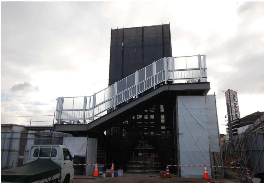
3 自由通路全景（線路西側から撮影）
