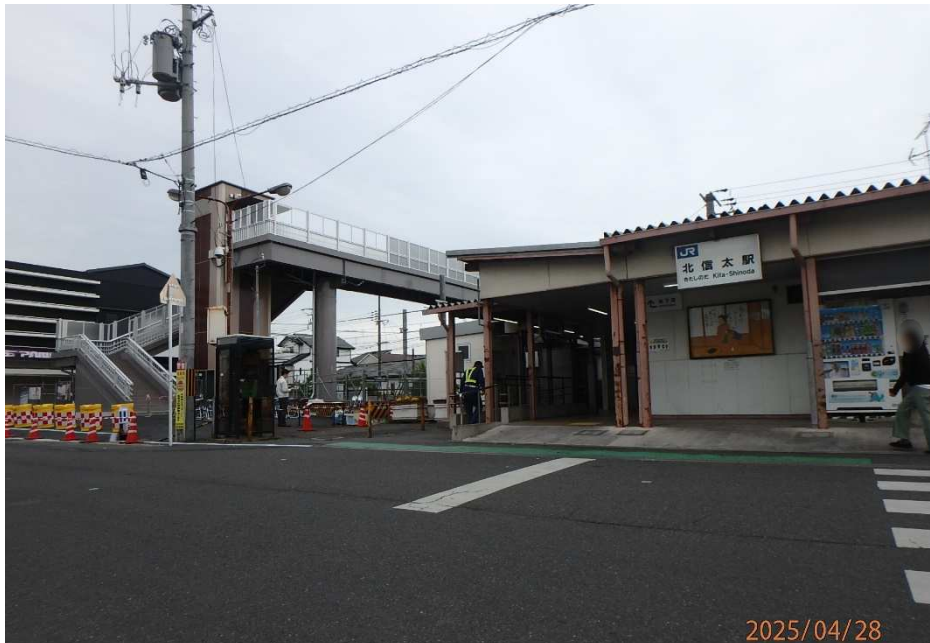
1 自由通路全景【駅東側】
