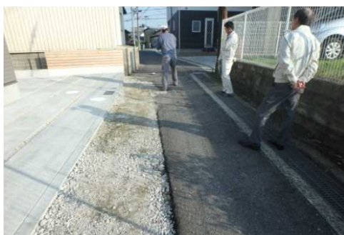
狭あい道路拡幅整備
