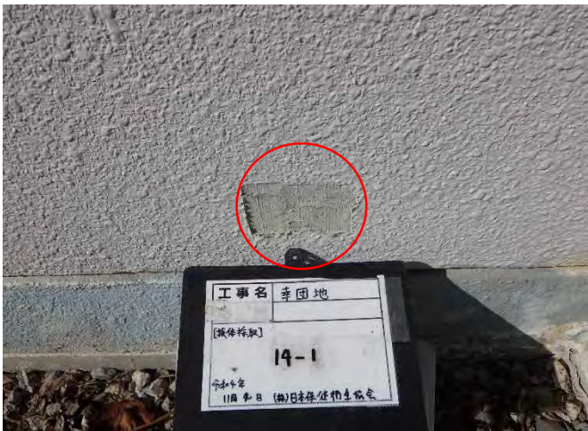
試料No.14 (採取後) 幸団地 36 棟 外壁 仕上塗材
