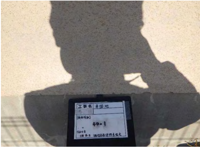
試料No.40 (採取前) 旭第二団地 8 棟 外壁 仕上塗材
