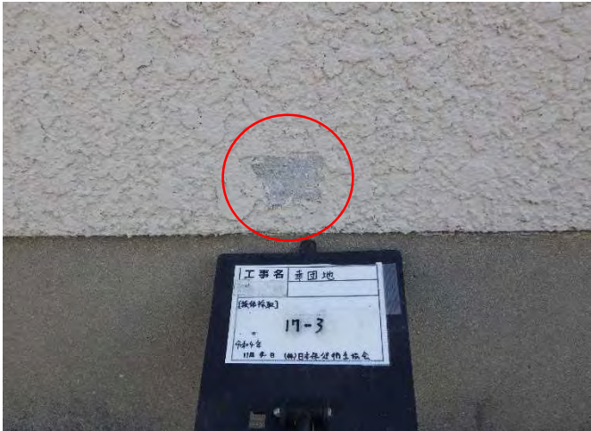
試料No.17 (採取後) 幸団地 39 棟 外壁 仕上塗材
