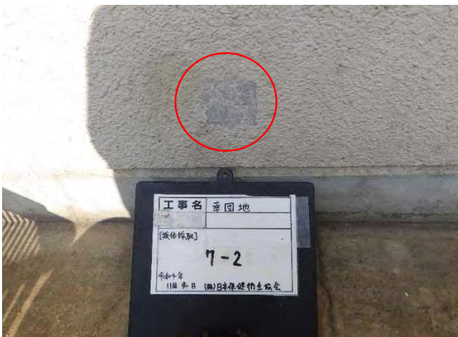
試料No.7 (採取後) 幸団地 28 棟 外壁 仕上塗材
