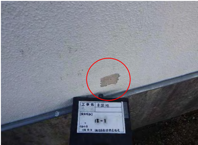
試料No.18 (採取後) 幸団地 40 棟 外壁 仕上塗材
