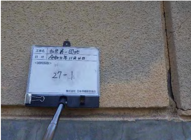
試料No.27 (採取前) 幸第二団地 49 棟 外壁 仕上塗材
