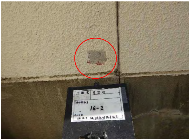
試料No.16 (採取後) 幸団地 38 棟 外壁 仕上塗材
