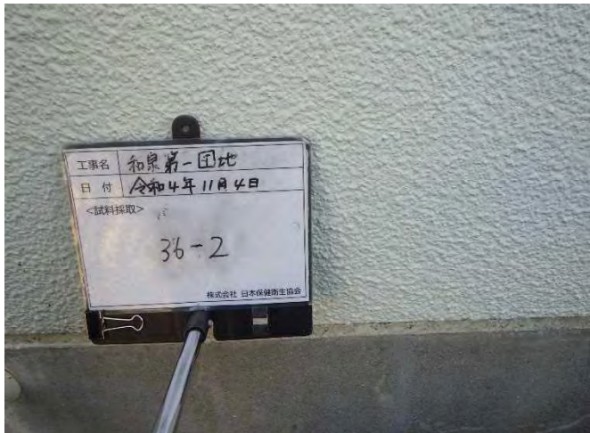
試料No.36 (採取前) 旭第一団地 23 棟 外壁 仕上塗材
