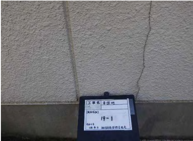
試料No.19 (採取前) 幸団地 A 棟 外壁 仕上塗材
