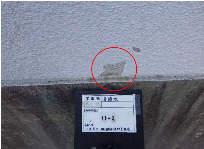
試料No.11 (採取後) 幸団地 33 棟 外壁 仕上塗材
