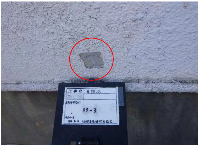
試料No.13 (採取後) 幸団地 35 棟 外壁 仕上塗材
