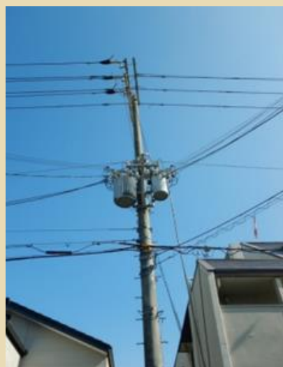
【既設電柱写真-1】
