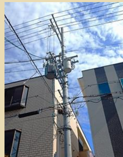
【既設電柱写真-2】
