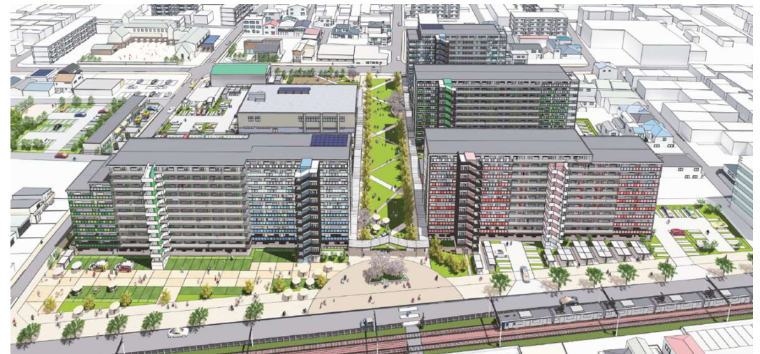
線路側から住棟を望む
