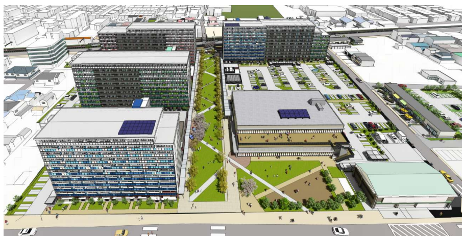
府道30号側から住棟を望む
