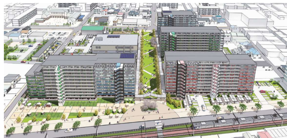
線路側から住棟を望む
