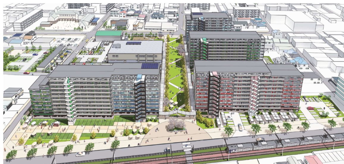
線路側から住棟を望む
