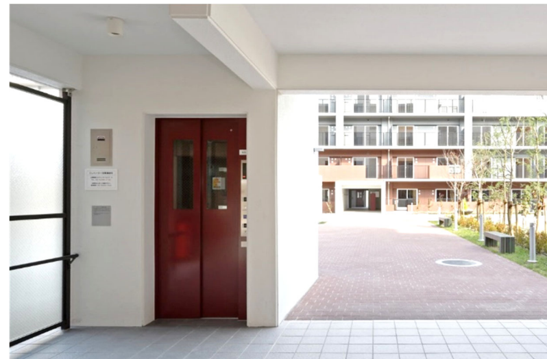
エレベーターの設置
