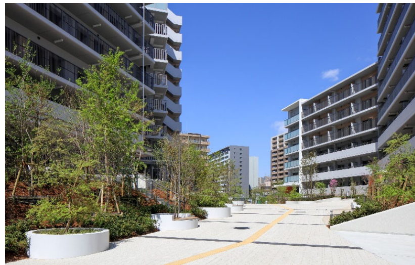
耐震性が確保された快適な新しい住宅
