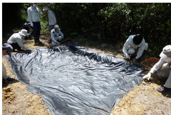
H湿地轍跡への防水シート張り
