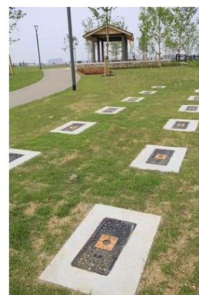
マンホールトイレ
