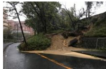
豪雨で崩落した道路沿いの緑地
