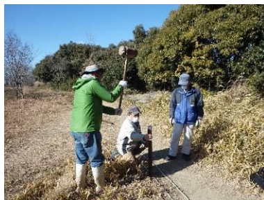
景観に配慮して、木杭を使用
