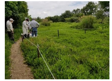
図面で現地の杭打の位置を確認
