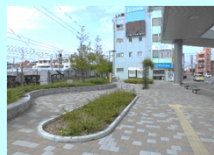
高質空間形成施設 和泉府中駅前広場
