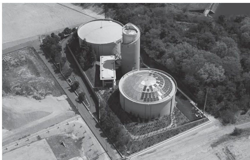
はつが野配水場
