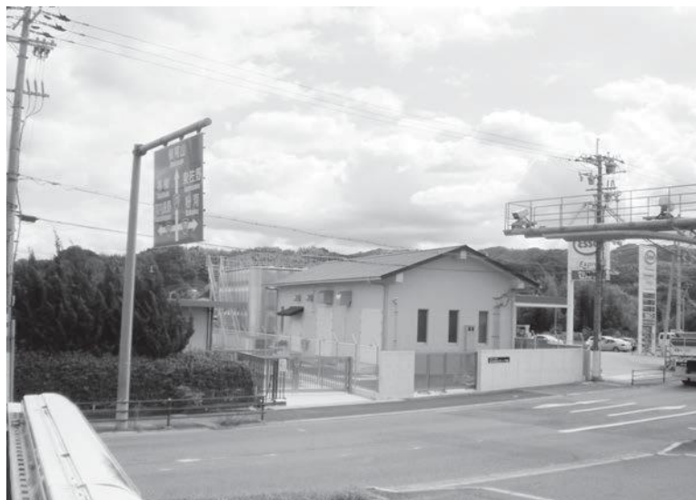
仏並加圧ポンプ場
