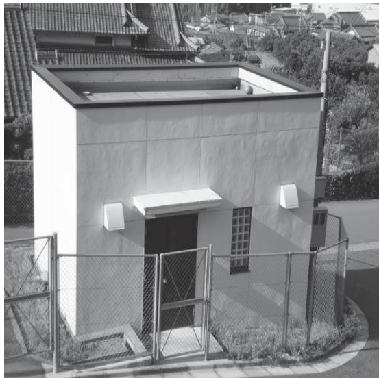
坪井加圧ポンプ所
