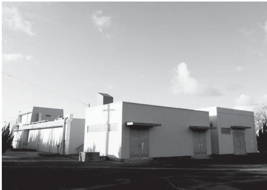
光明台高区配水場
