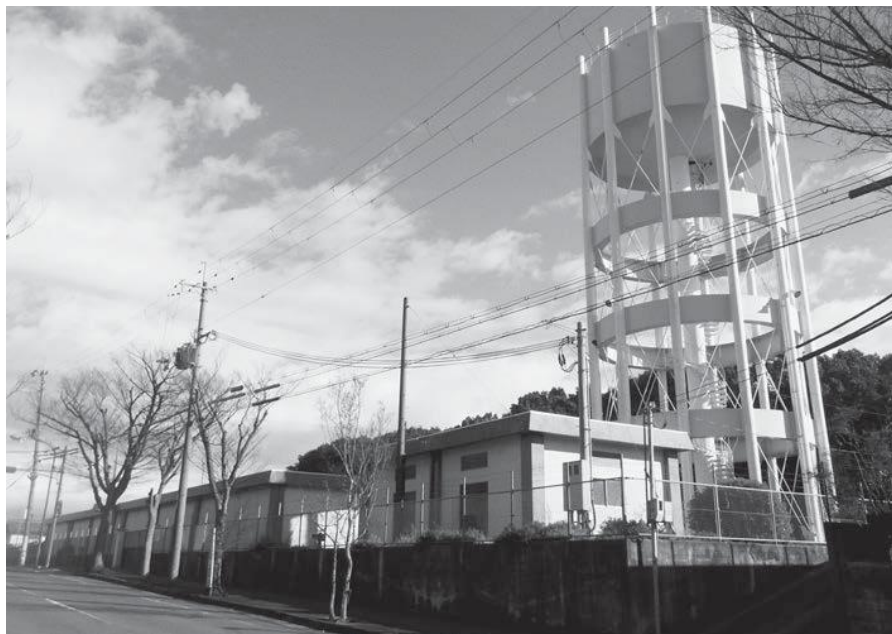
鶴山台配水場
