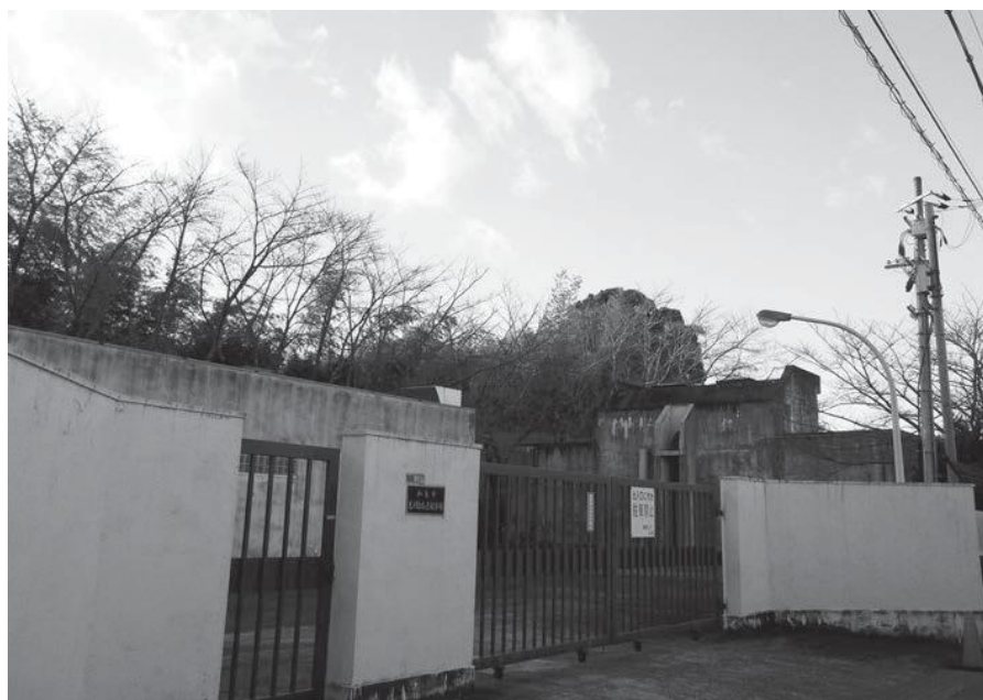
光明台低区配水場
