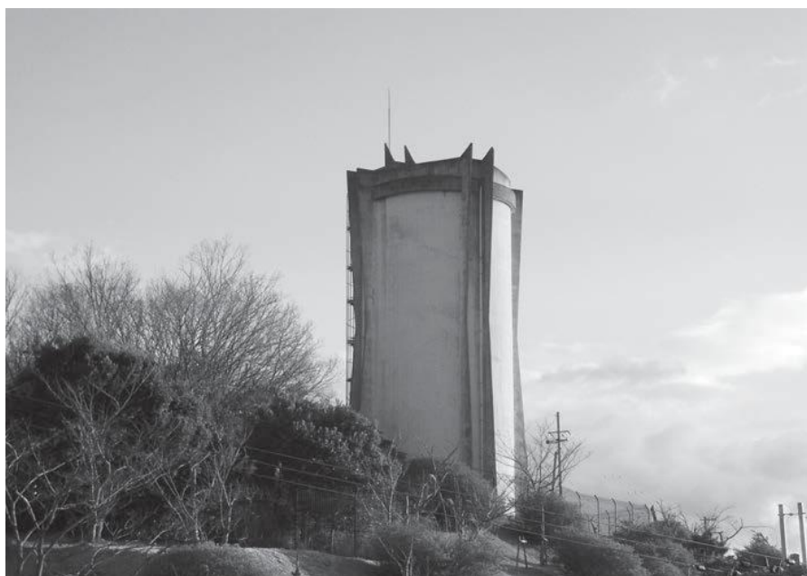
光明台高区配水塔
