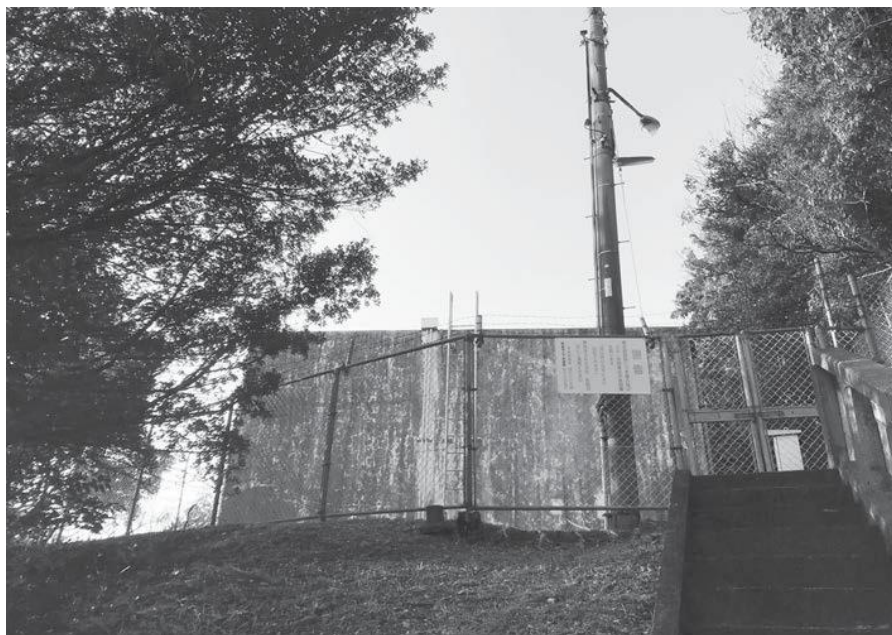
南面利配水池
