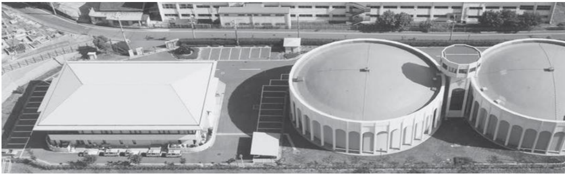
中央受配水場
