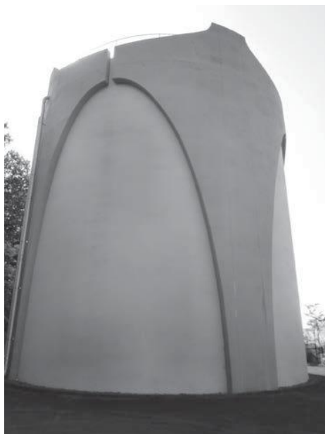
みずき台配水塔
