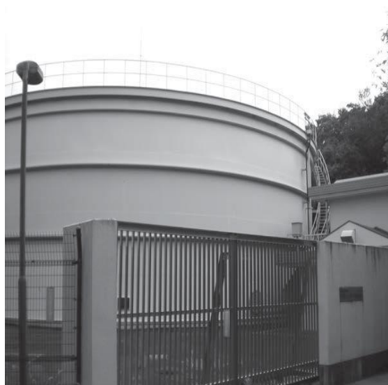
テクノステージ配水池
