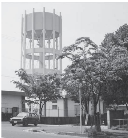
鶴山台配水場
