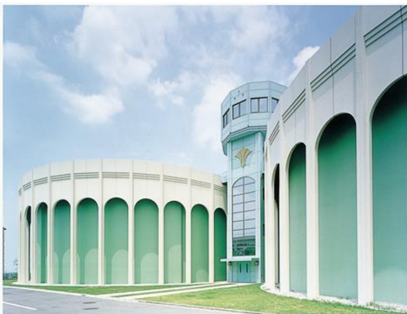
中央受配水場
