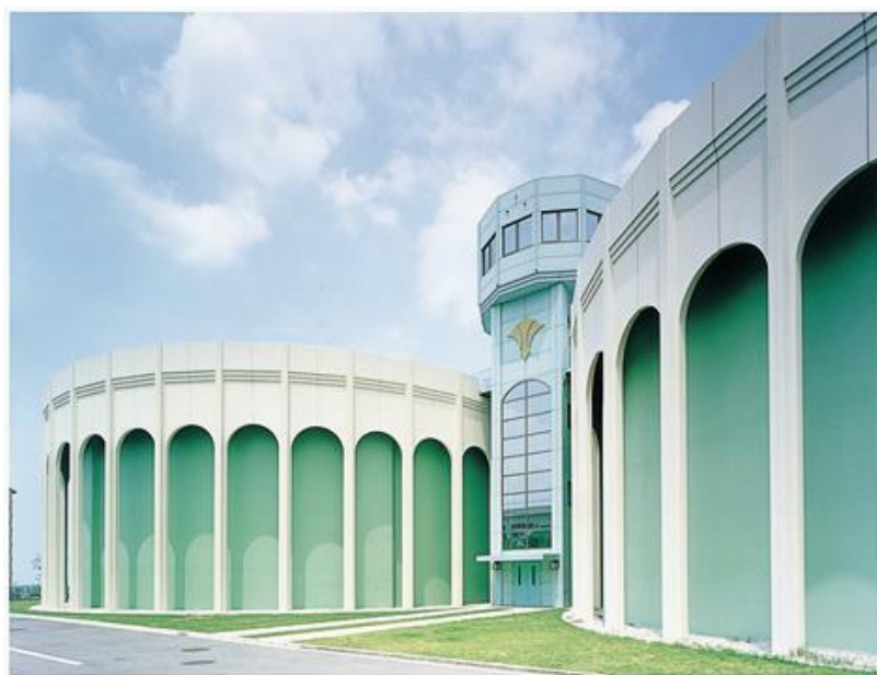
中央受配水場
