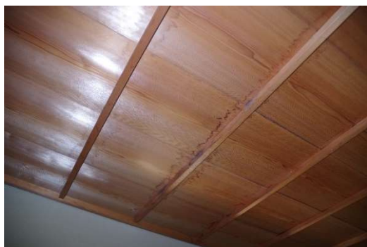
九畳の間 天井の雨染み
