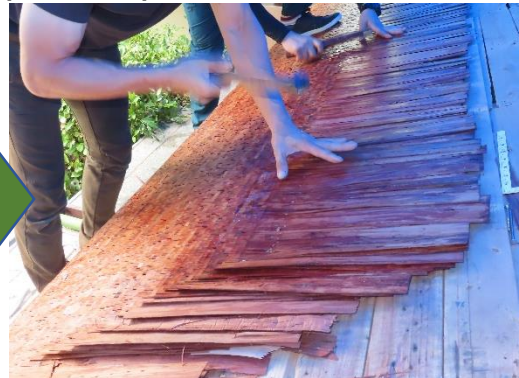
7 正門屋根檜皮葺き作業(R6.6)
