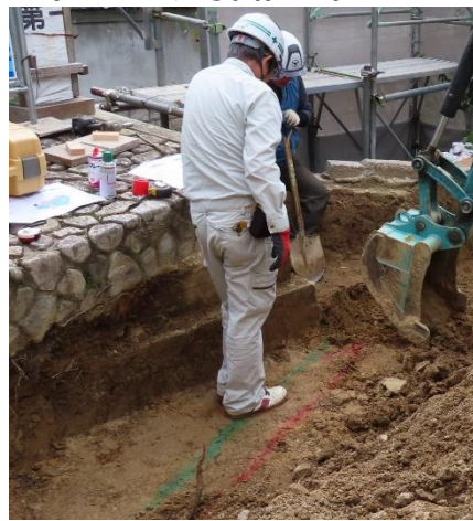
2 正門基礎掘削(R5.10)
