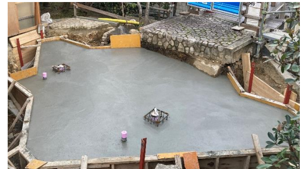
4 基礎コンクリート打設
