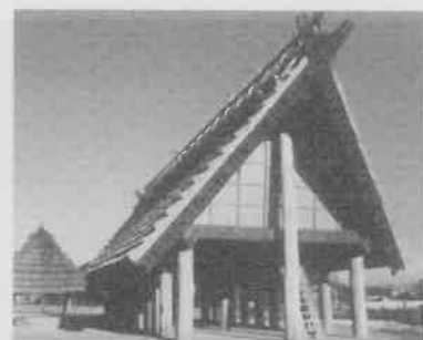
池上曾根史跡公園「いずみの高殿」
