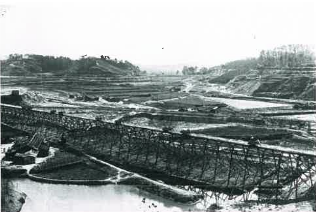
光明池本堤防工事の様子 (光明池土地改良区蔵)
