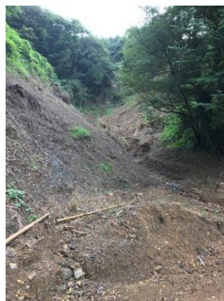
写真2 みかん山の土砂崩れ
