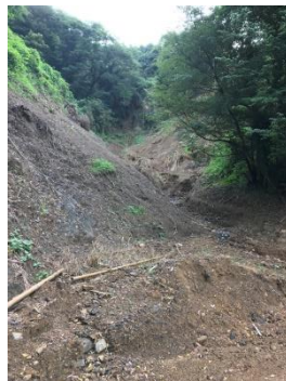
写真2 みかん山の土砂崩れ
