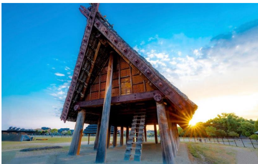
池上曽根史跡公園 いずみの高殿
