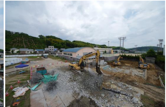
プール解体工事の様子
