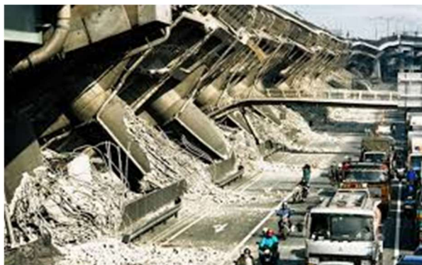
上の写真は、地震で倒れた高速道路のようすです
